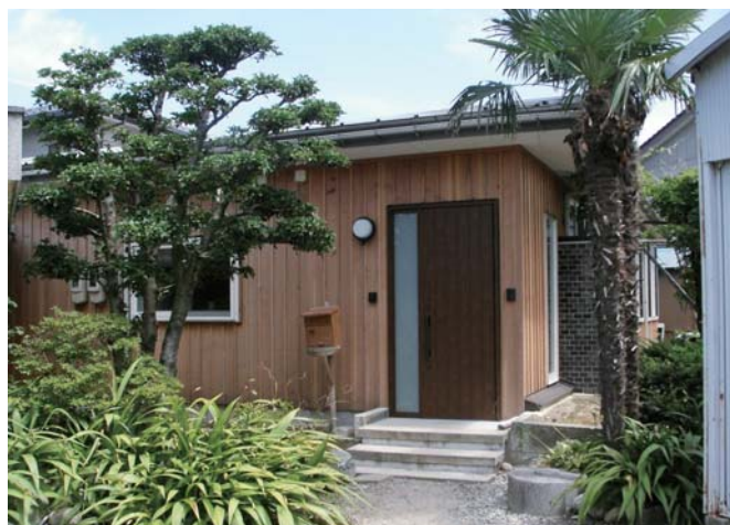
断熱改修を行い外壁、建具改修。
