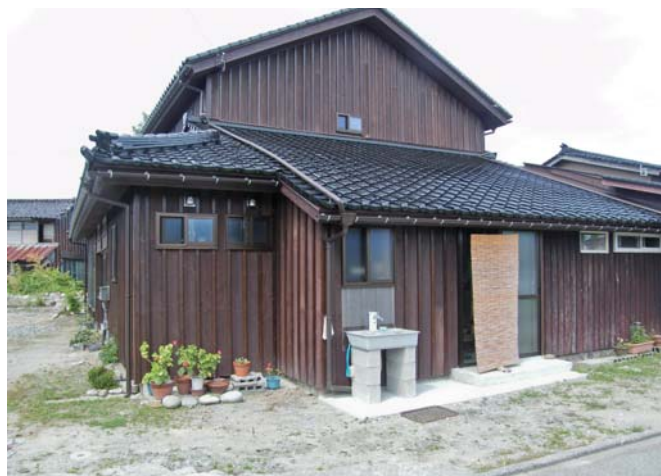
外壁は、杉板にオスモカラーの塗装としています。断熱改修、耐震補強を行い、補助金をいただきました。
