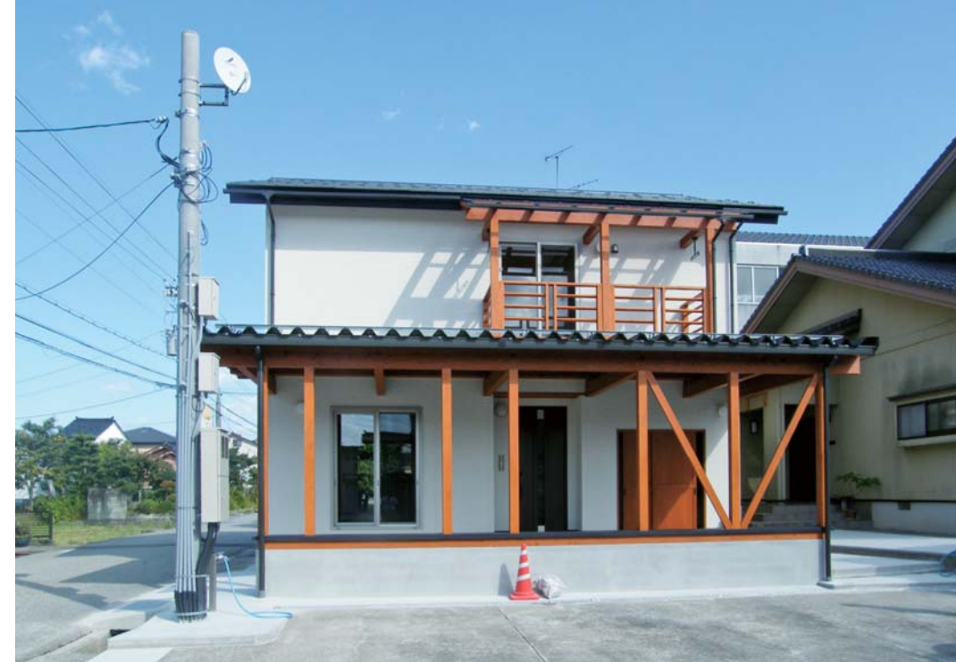
防火地域で延焼のない所で木材を見せて柔らかなイメージにしています。
